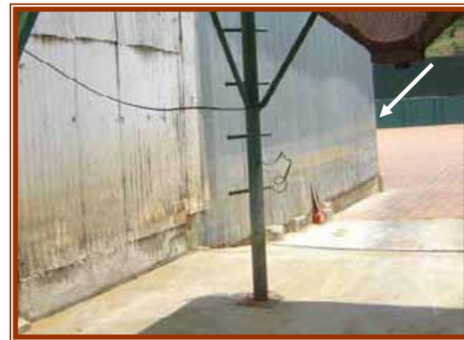
Seña de la inundación del desbordamiento del río Guacalate durante la tormenta Stan en 2005 en finca Pastores, llegó a más de 2m sobre el nivel de los patios de secado. Foto: DafneE
