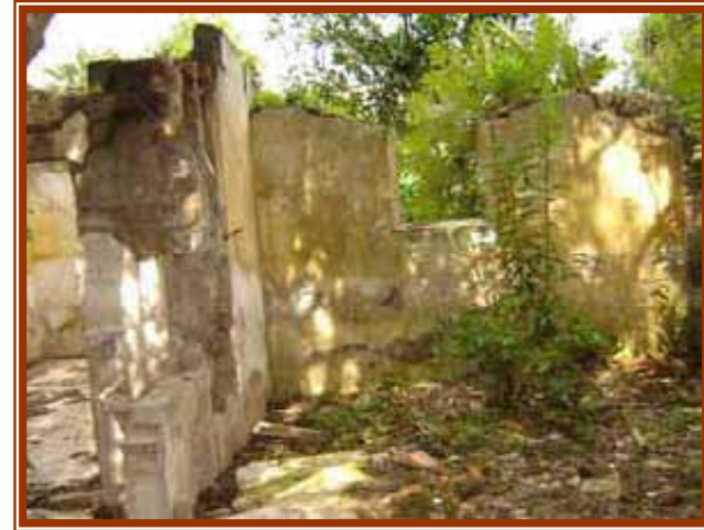
Finca Las Margaritas, actualmente anexada a la finca Retana, se encuentra en ruinas. Foto: DafneE
