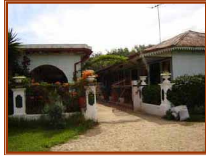
Casa patronal que cuenta aún con infraestructura colonial en la finca el San Rafael Uriás. Foto: DafneE
